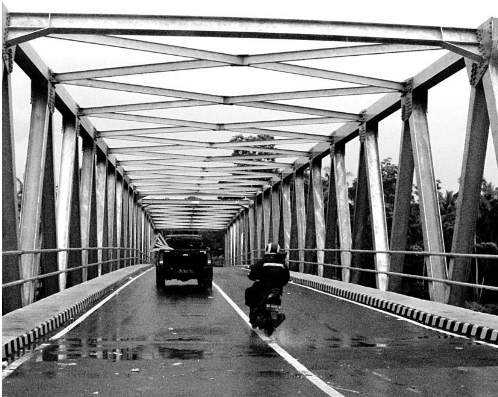
AKTIFITAS LANCAR: Nampak lalu lintas kendaraan yang mulai melintasi jembatan baru di Desa Tanjung Agung.
