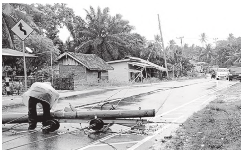
ROBOH: Nampak tiang listrik roboh akibat hujan dan angin kencang yang terjadi di Kaur kemarin.
