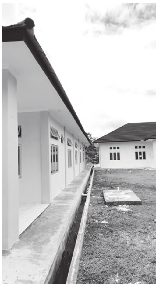
SELESAI: Inilah bentuk gedung isolasi, ruang rekontaminasi dan kamar mayat yang sudah selesai dibangun.
