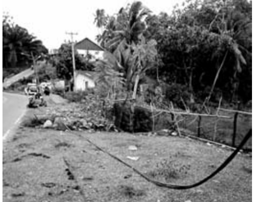
PERBAIKAN: PLN saat memperbaiki jaringan yang putus.
