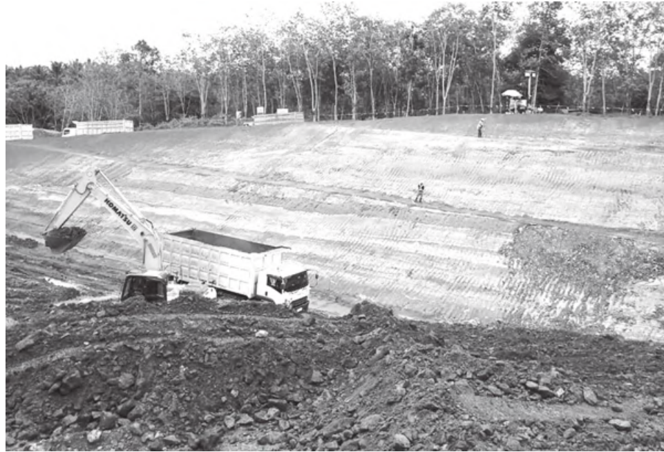
TOL: Pembangunan jalan tol yang melewati wilayah Kabupaten Benteng terus dilaksanakan.
