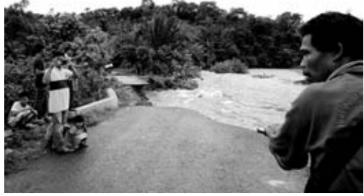
PUTUS: Inilah kondisi jalan yang putus diterjang derasnya air Padang Gucci.
