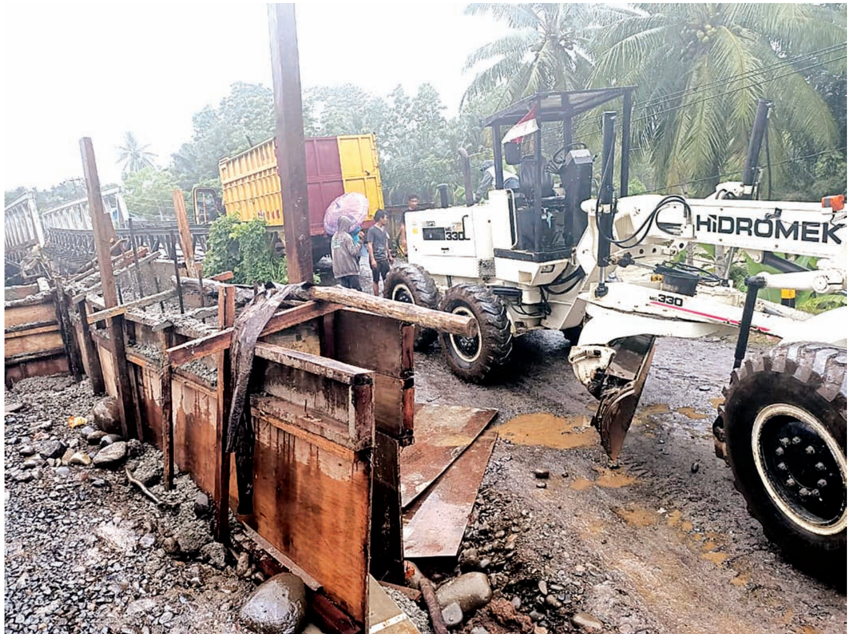
JEBOL: Lantai jembatan darurat di Desa Tanjung Agung, Kecamatan Tanjung Agung Palik jebol karena sudah lapuk dan terus dilintasi kendaraan.
