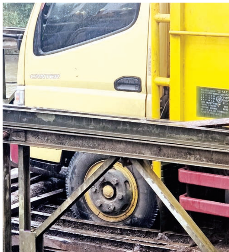
JEBOL: Lantai jembatan darurat di Desa Tanjung Agung, Kecamatan Tanjung Agung Palik jebol karena sudah lapuk dan terus dilintasi kendaraan.
