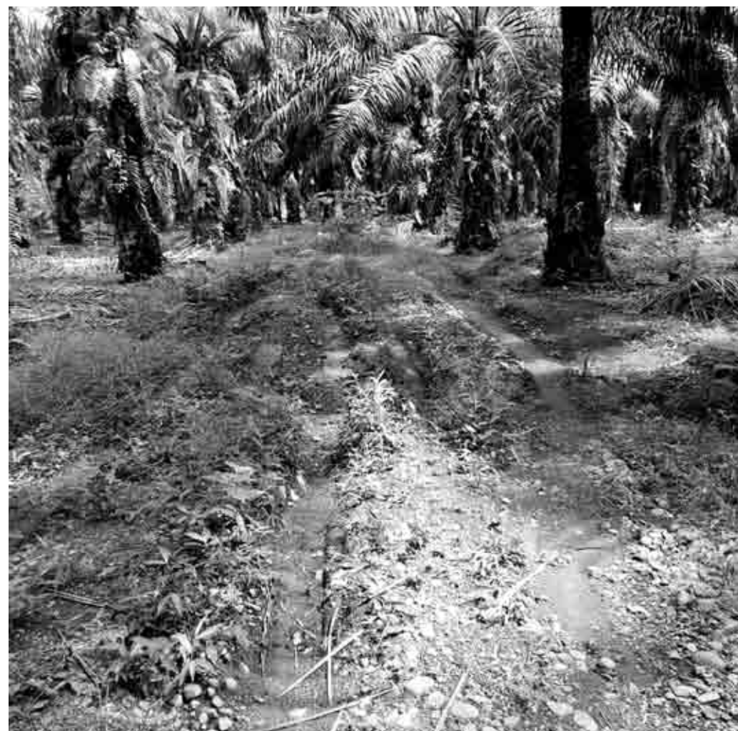
BELUM SELESAI: Lokasi pekerjaan pembangunan jalan di Desa Padang Genting yang menggunakan dana desa.
