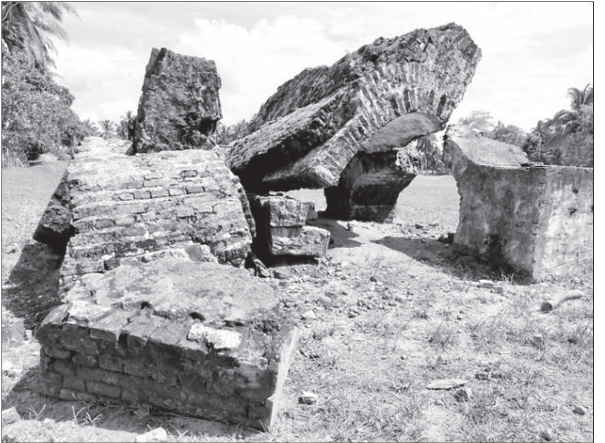
DISELAMATKAN: Areal dan puing sisa bangunan Benteng Anna ini, mulai diselamatkan tahun depan dengan dibangun bangunan pengaman erosi Sungai Selagan.
