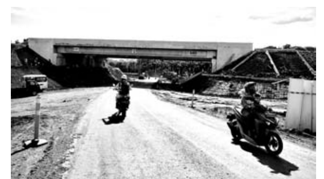
PROGRES: Perkembangan pembangunan tol yang ada di wilayah Kabupaten Bengkulu Tengah.
